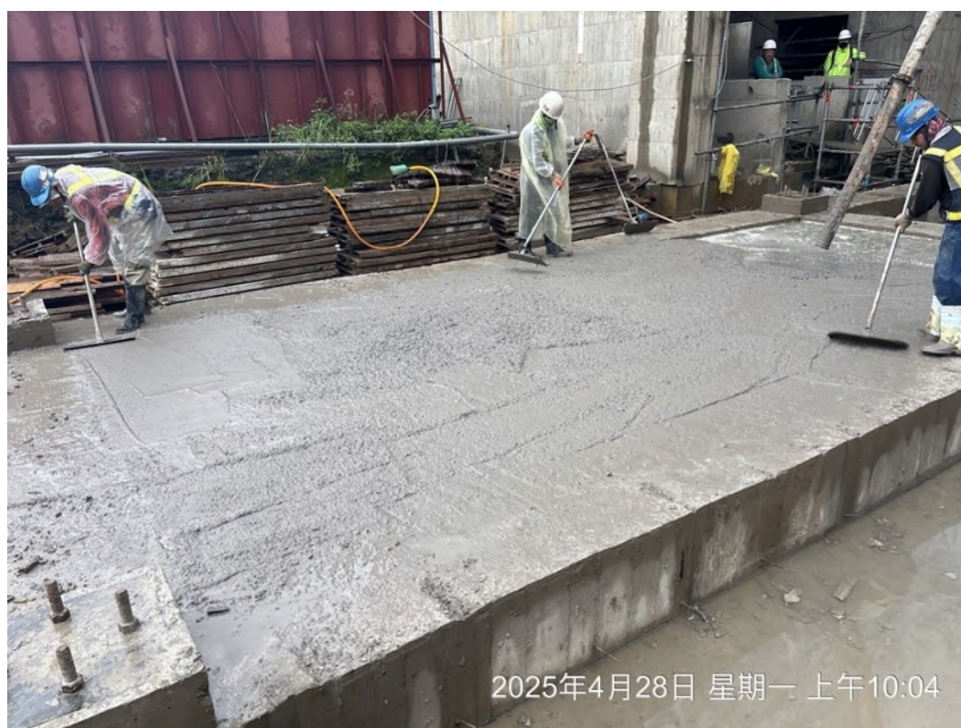
▲圖說：三鶯線鶯歌福德一路 CLSM 回填澆置作業 (來源：新北市政府捷運工程局)
