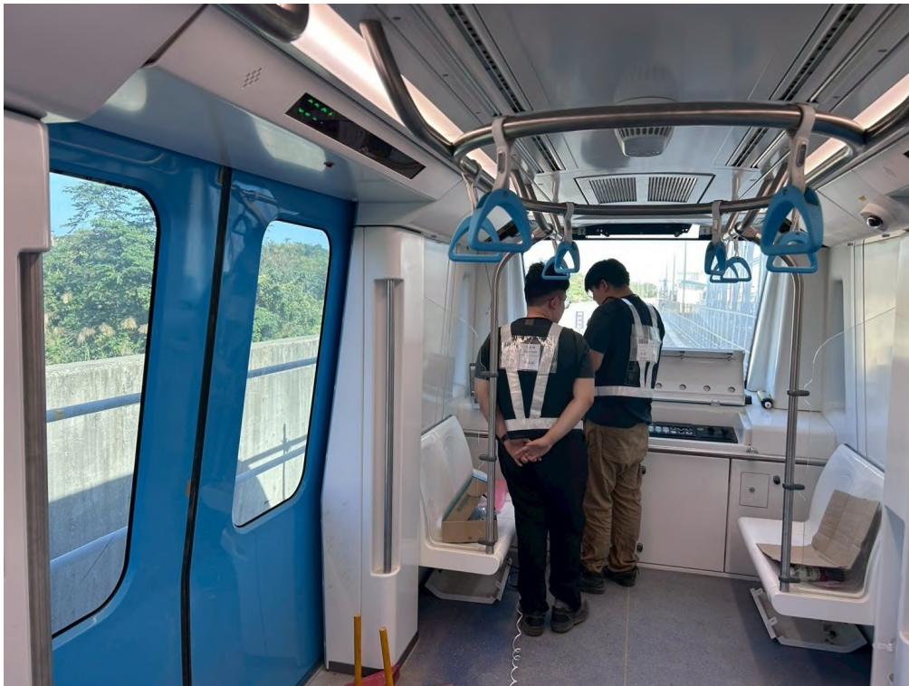
圖 5. 三鶯線-號誌系統 CBTC 穩定性測試前置作業
