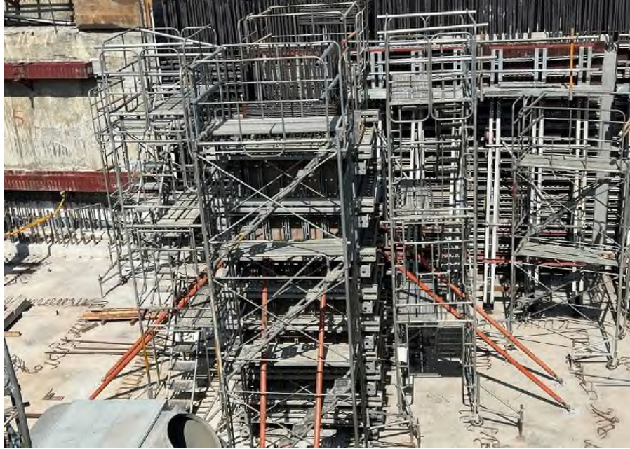
圖 12.環狀線南北環段-CF680C 北機廠 B1 區 B1102 單元柱模板組立完成
