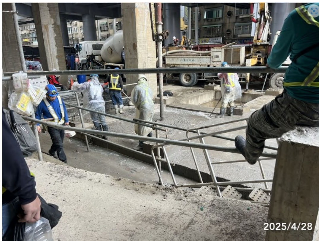
▲圖說：三鶯線 CLSM 筏基灌漿作業(來源：新北市政府捷運工程局)
