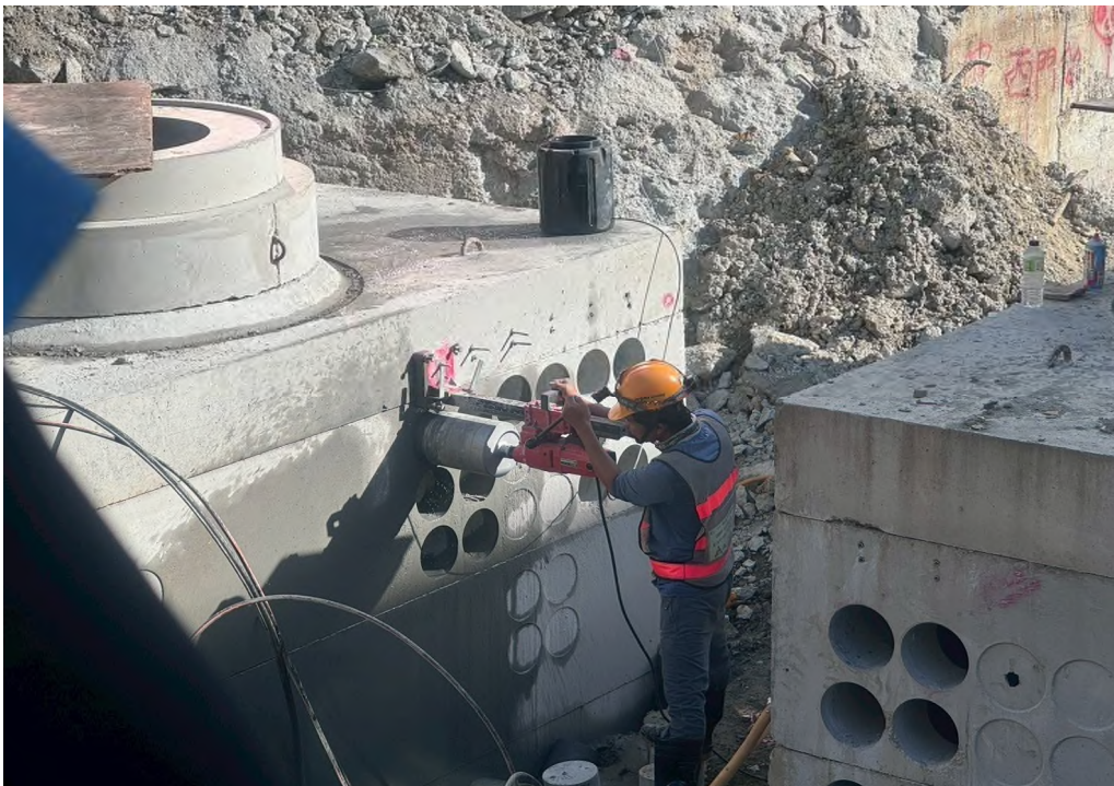
圖 7. 萬大中和線-CQ860 中正路台電高壓管道配置處洗孔 資料來源：捷運工程局工程管理科
