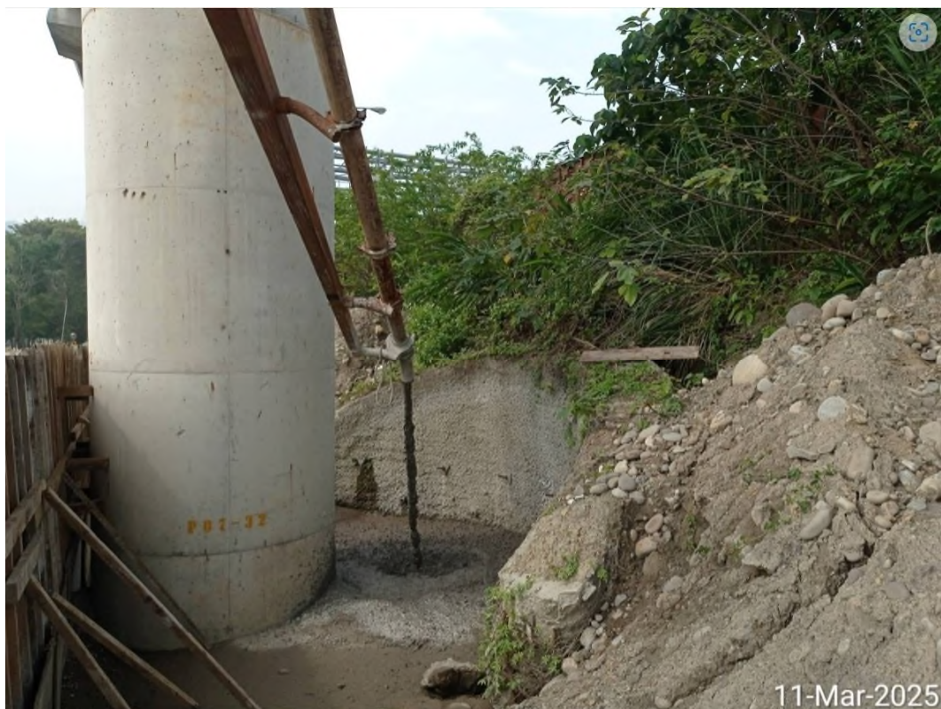
▲圖說：三鶯線 CLSM 灌漿作業(來源：新北市政府捷運工程局)
