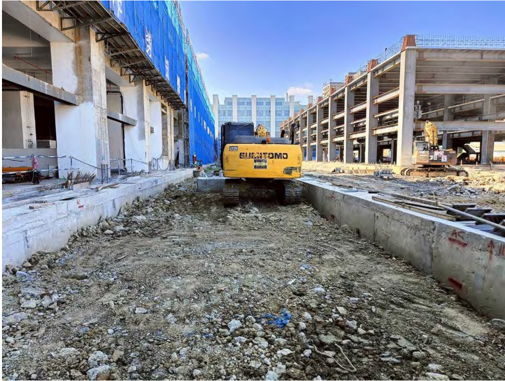
圖 6. 萬大中和線-CQ871 機廠-維修工廠西側道路及 TK401 軌整地 資料來源：捷運工程局工程管理科
