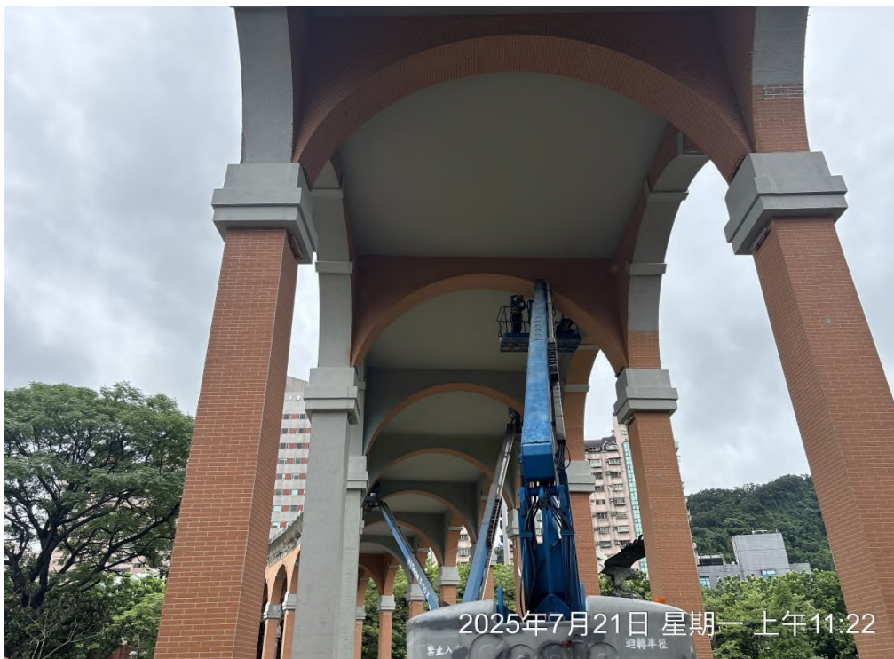
圖4. 三鶯線-飛鳶廣場仿石漆噴漆作業
