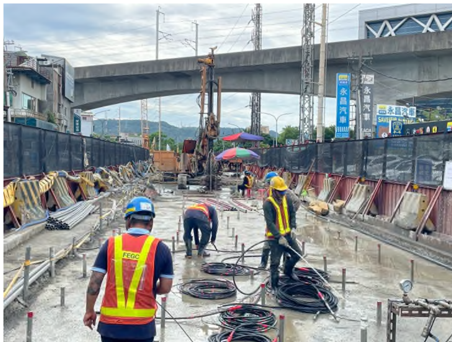
圖 10. 土城樹林線-CQ890 中正路-P1820 基礎鋼筋綁 資料來源：捷運工程局工程管理科
