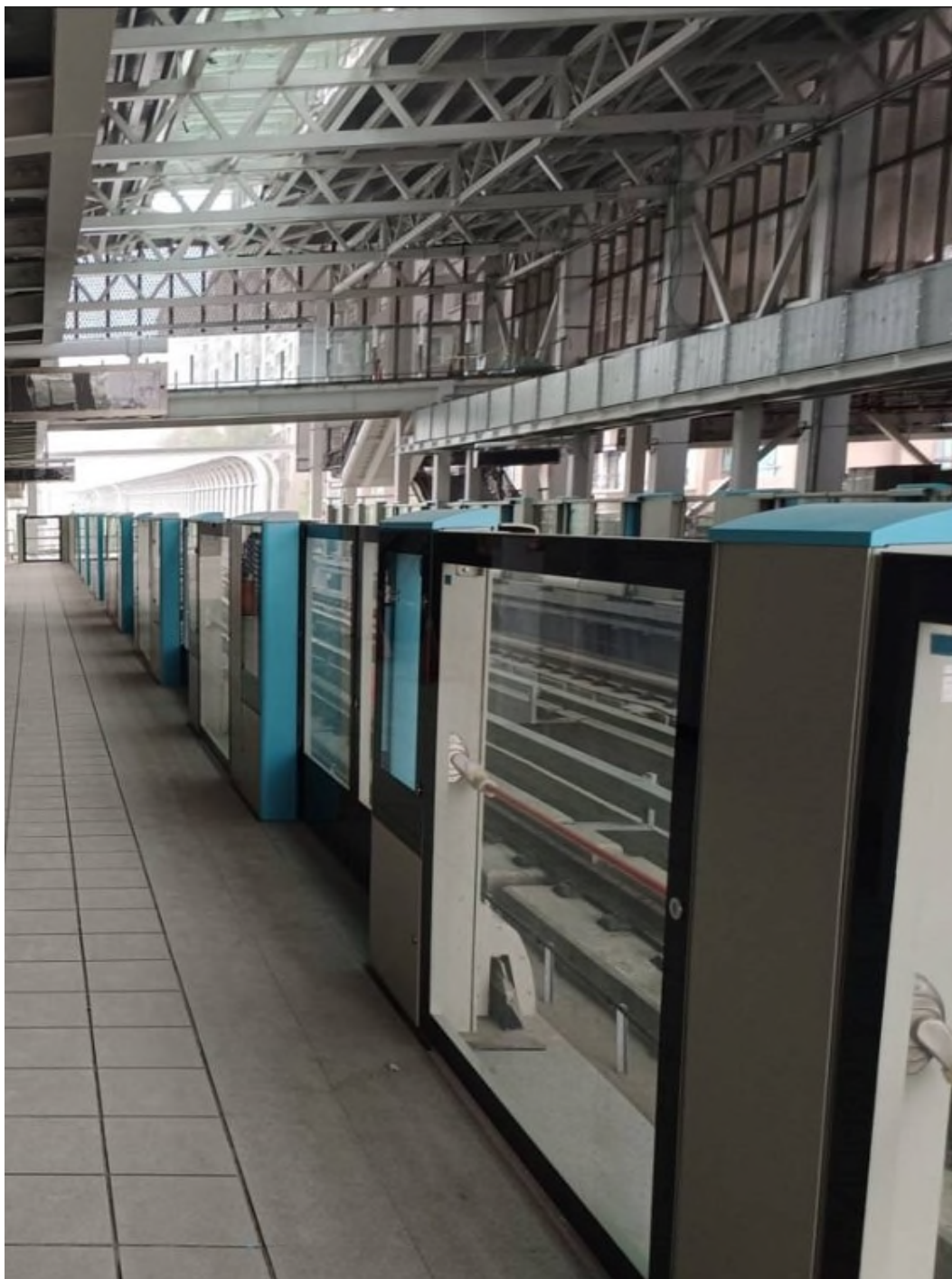
▲圖說：施工中捷運三鶯線月台門(資料來源：新北市政府捷運工程局局網)
