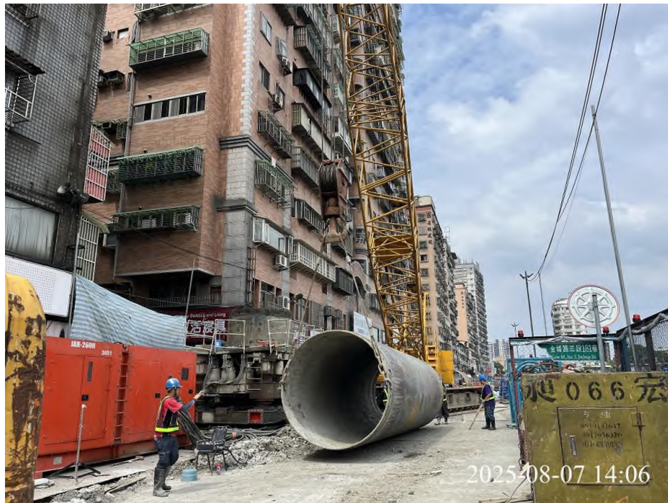
圖 9.土城樹林線-CQ880A LG09 站(金城路)拔樁機具拆卸場地整理 資料來源：捷運工程局工程管理科
