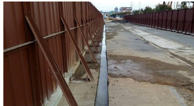
簡易排水設施
