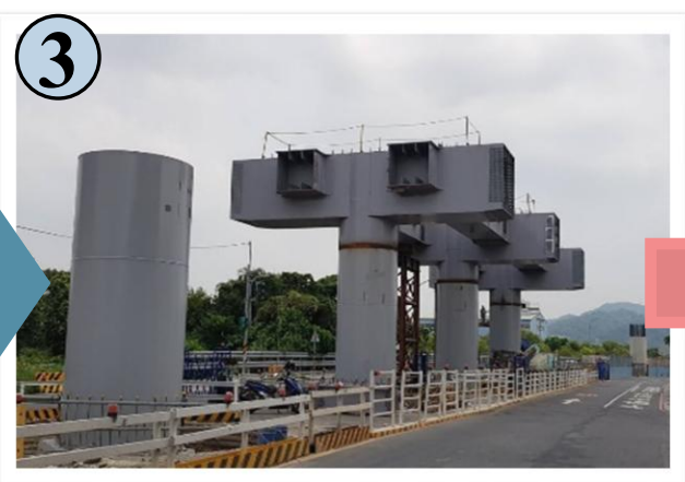
鋼柱/鋼帽梁吊裝
