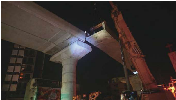
圖 10 P01-30 ~ P01-31 吊裝作業
