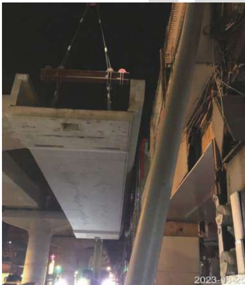
圖 16 緊貼鄰房吊掛作業
