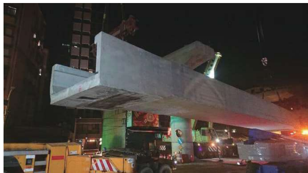
圖 9 P01-31~P01-32 吊裝作業
