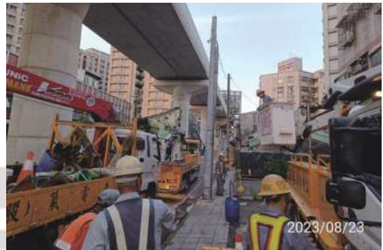
圖 12 電桿復原作業
