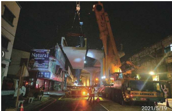
圖 4 鶯桃路 FST 預鑄梁吊裝
