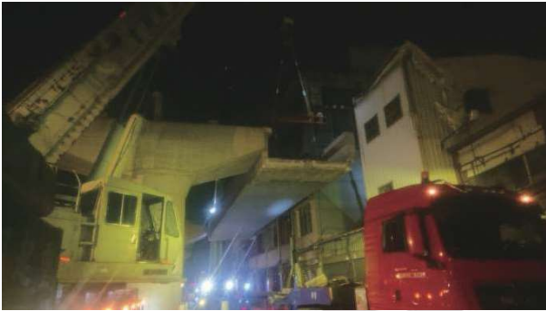
圖 15 緊貼鄰房吊掛作業
