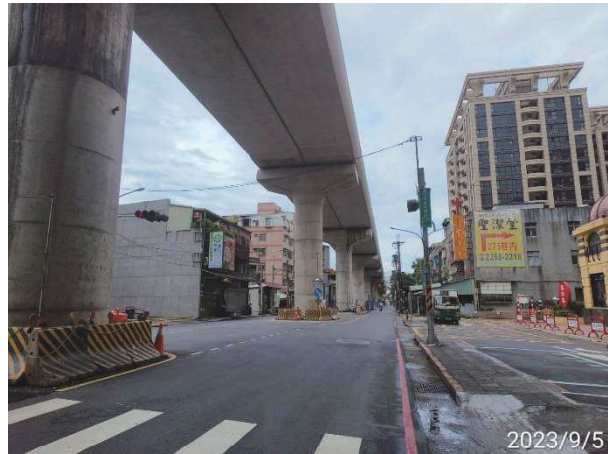
圖 17 P01-23 ~ P01-32 預鑄梁吊裝完成
