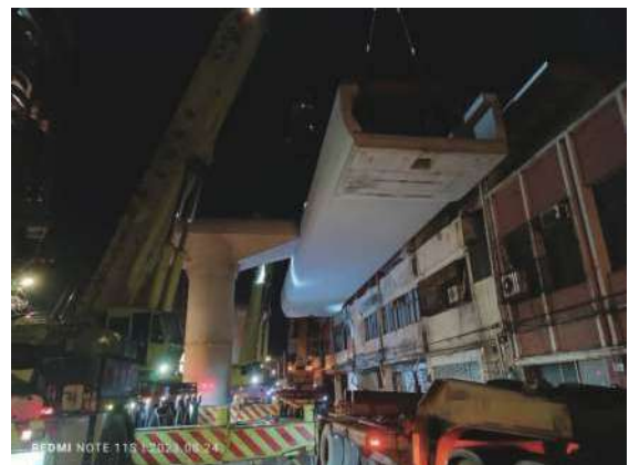
圖 14 緊貼鄰房吊掛作業
