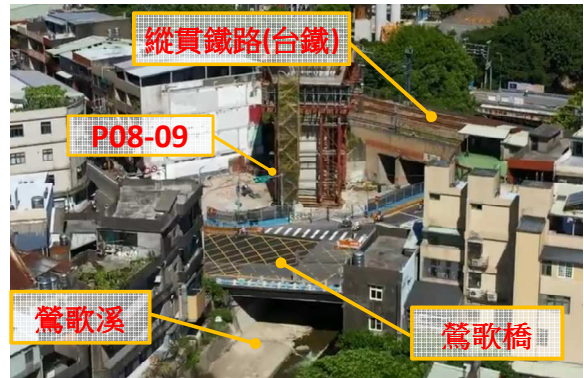
圖十一 高架橋基礎施工空間狹小
