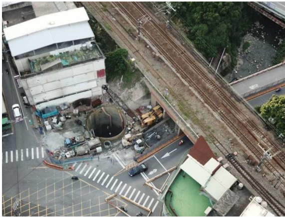
(b) 墩柱基礎緊鄰臺鐵路與鶯歌橋
