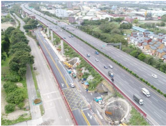
(a) 墩柱基礎座落國道三號邊坡
