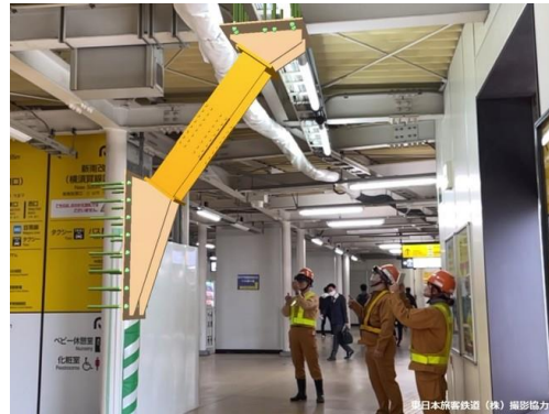
圖七 透過 MR 檢核結構施作位置。 （資料來源: [1]）
