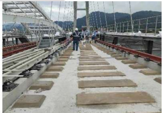
照片 17 特殊軌彈性基鈹承載面環氧樹脂砂漿施作
