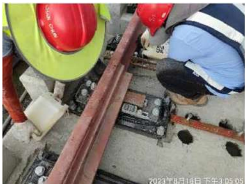
照片 15 特殊軌基鈹錨定螺栓孔灌注環氧樹脂
