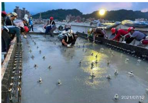
照片 6 特殊軌道床版混凝土澆置
