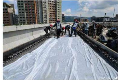
照片 7 特殊軌道床版混凝土養護
