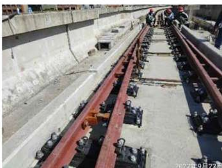
照片 9 特殊軌尖軌段調整架安裝
