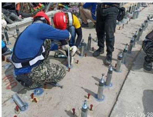
照片 1 基鈹螺栓預留孔施作
