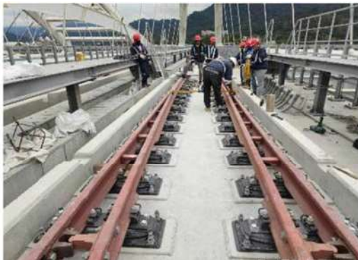
照片 19 特殊軌鋼軌安裝及線形調整
