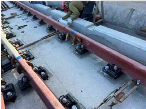
照片 14 特殊軌基鈹錨定螺栓孔灌注環氧樹脂
