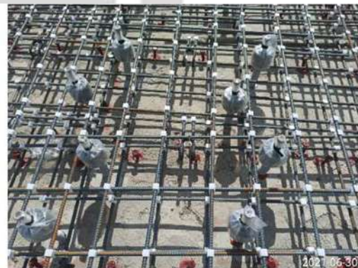
照片 2 基鈹螺栓預留孔施作完成
