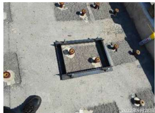
照片 16 基座混凝土毛面先以環氧樹脂塗佈
