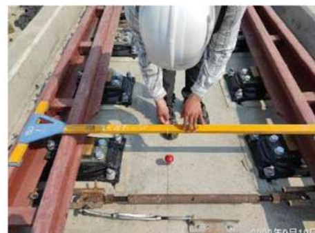
照片 12 特殊軌尖軌段軌道中心檢核
