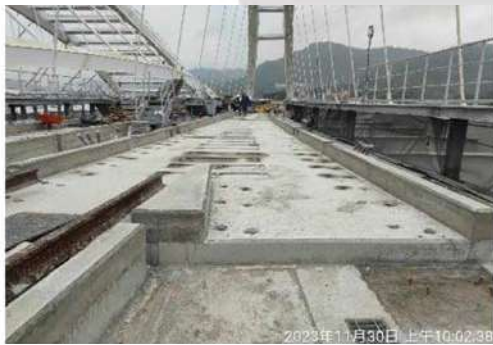
照片 5 澆置後將保麗龍板移除，基鈹位置留出 2.5cm 深之凹槽
