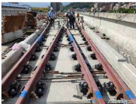
照片 8 特殊軌導軌段調整架安裝
