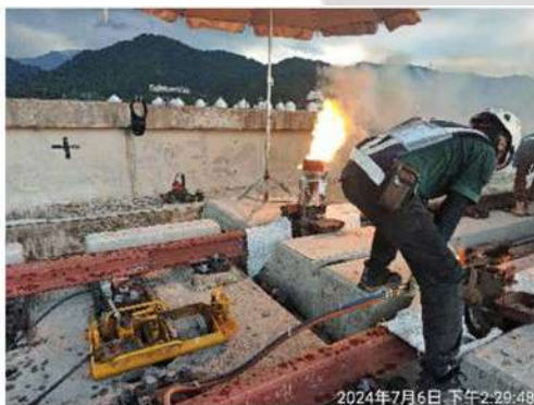
照片 20 特殊軌鋼軌接頭處鋁熱銲
