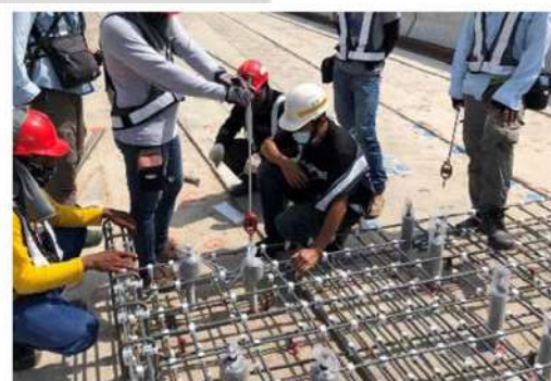
照片 3 基鈹螺栓預留孔高程檢測
