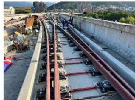
照片 10 特殊軌彈性基鈹調整架安裝
