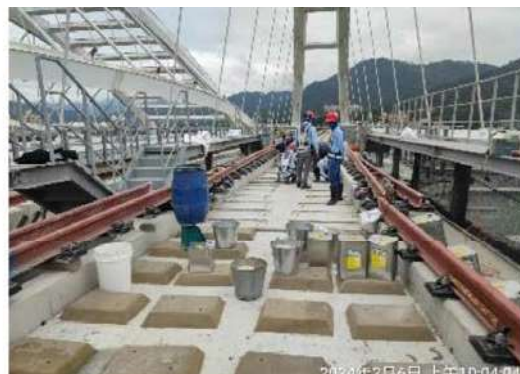
照片 18 特殊軌彈性基鈹承載面環氧樹脂砂漿施作
