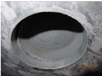
(b) P1218LF 調坡板銑空深度照片
