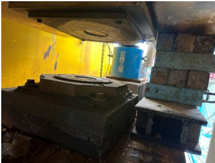
圖 3.3-3 P1216 鋼箱梁頂升後插銷卡在上盤之實際照片
