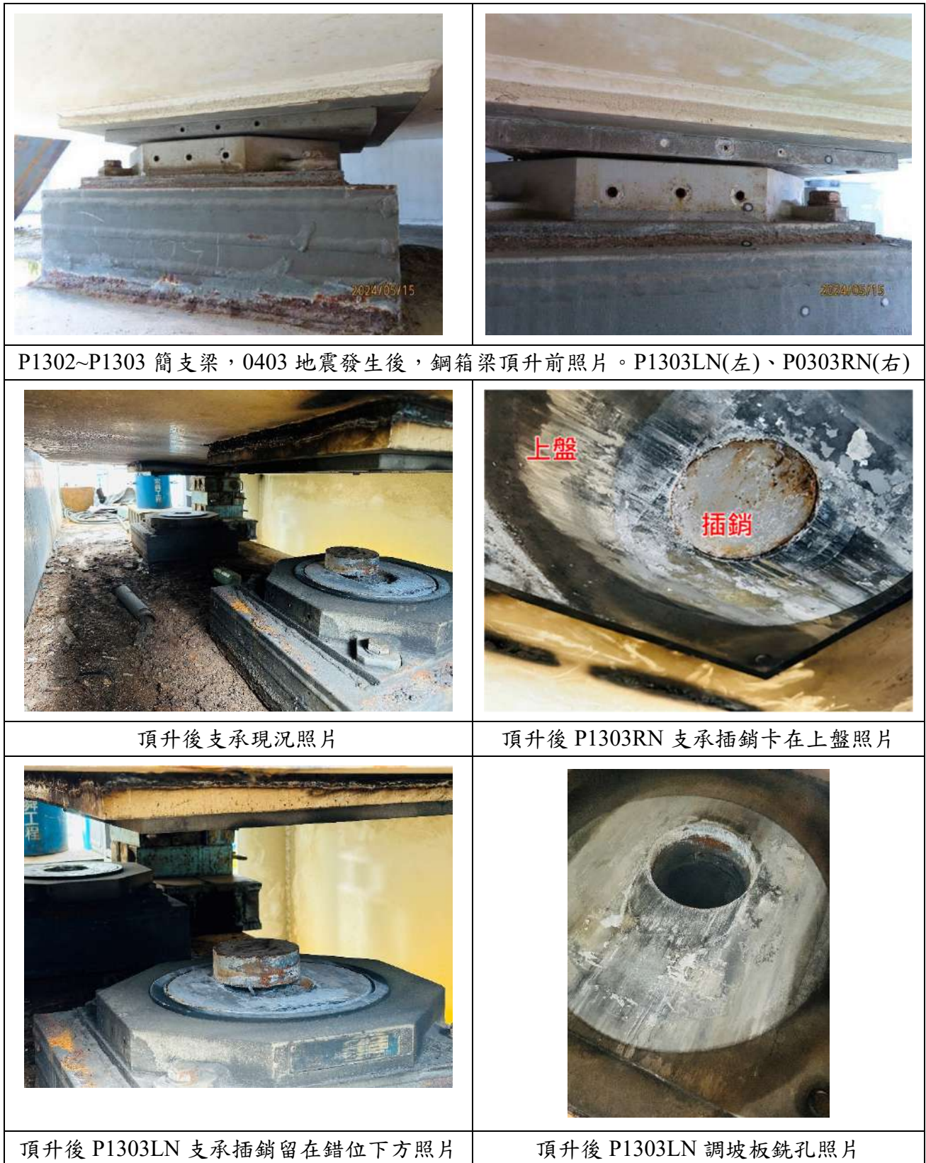
圖 7.2-4 P1302~P1303 簡支梁復原工程，鋼箱梁頂升前後之照片
