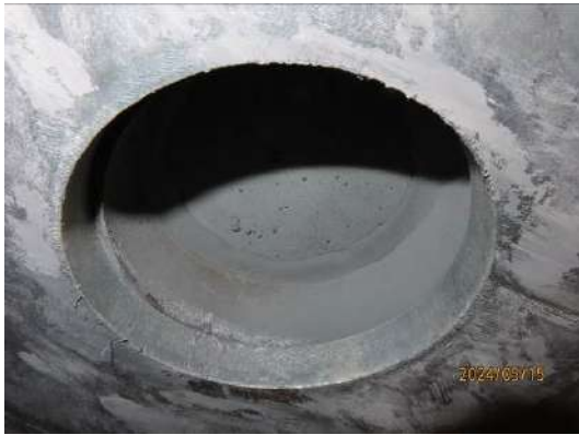
(b) P1218LF 調坡板銑空深度照片
