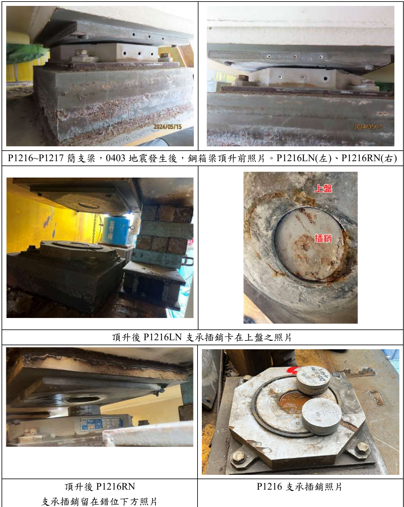
圖 7.2-3 P1216~1217 簡支梁復原工程，鋼箱梁頂升前後之現況照片
