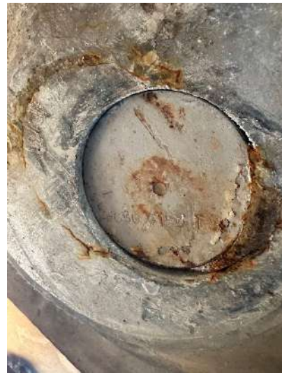
圖 3.3-3 P1216 鋼箱梁頂升後插銷卡在上盤之實際照片
