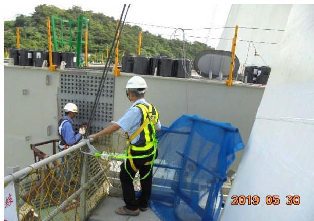
圖九 鋼桁架梁螺栓穿鎖作業[11]
