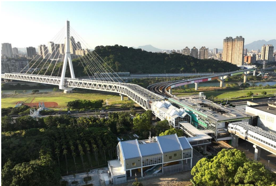
安心橋在設計、施工過程兼顧環境保護與安全性、耐久性考量。
