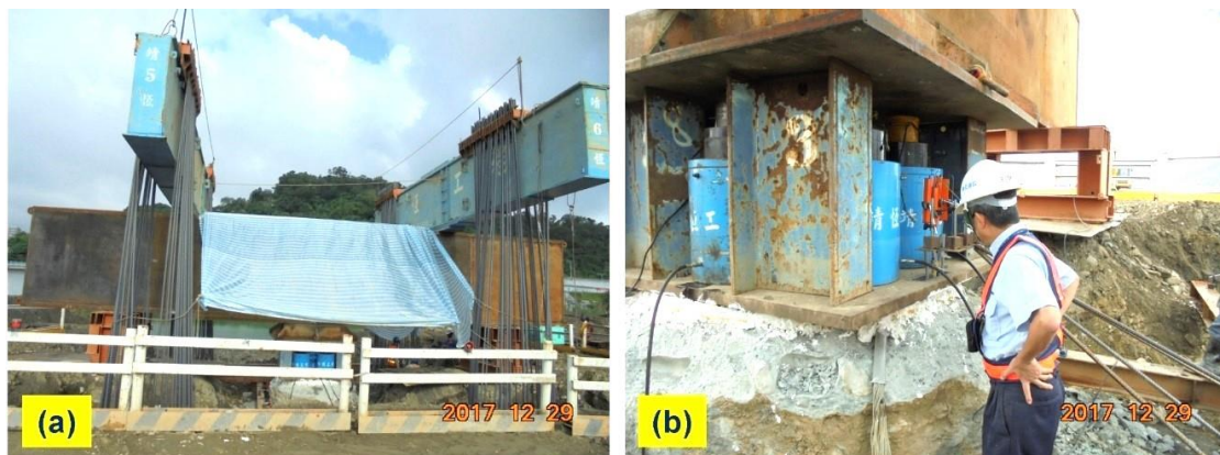
圖十三 試樁設備：(a)現場組裝情況，(b)組裝情況查驗。
