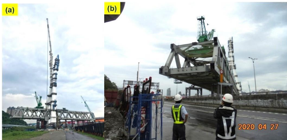
圖八 TFES 的現場照片: (a)近鋼橋塔段，(b)近 P9-18 段。
