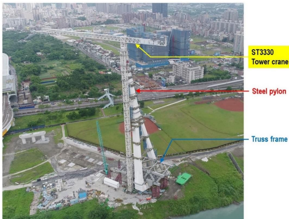
圖五 ST3330 塔吊照片
