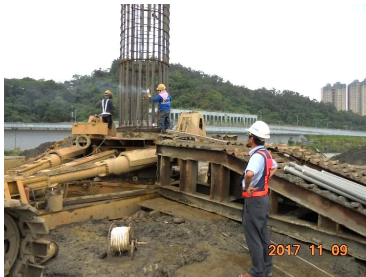
圖十 基樁施工鋼筋籠吊裝作業情形
