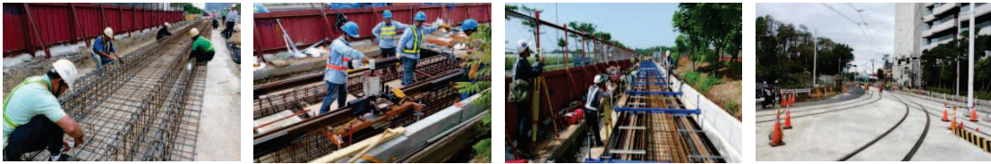
圖五 嵌埋式軌道施工流程
