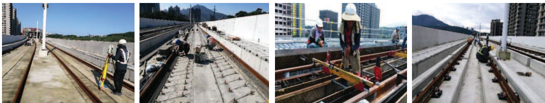
圖四 無道碴道床基座式軌道施作施工流程
