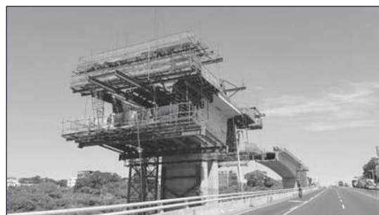
圖 11 地盤改良後順利施工之 p17 墩柱
