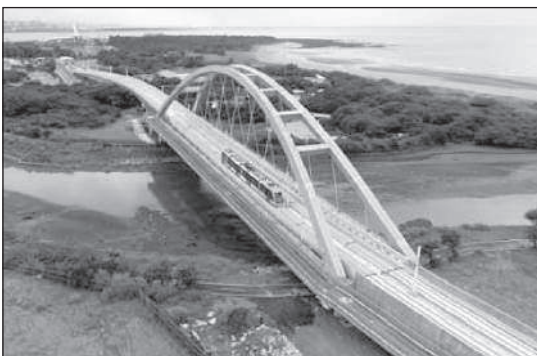
圖 18 遠眺臺灣海峽之藍海橋
