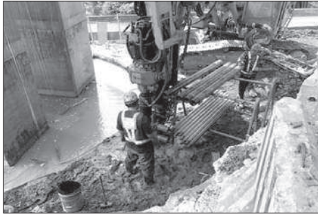
圖 8 地盤改良雙環塞灌漿施工
