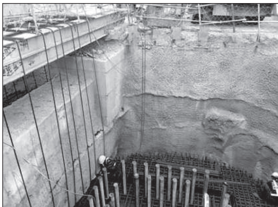
圖 5 台電 161 kV 高壓電纜吊掛示意圖
