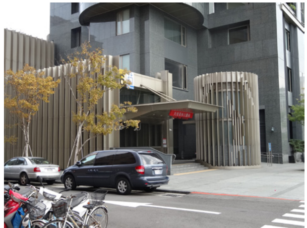
圖3 基地西側捷運站6號出入口
