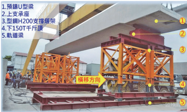
圖 9 預鑄梁場橫移工法演練
