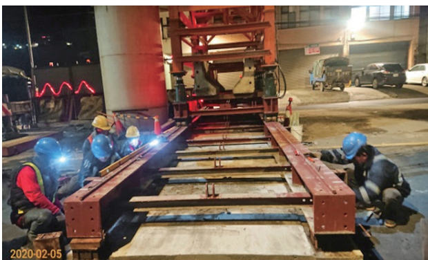
圖 10 軌道地梁安裝
