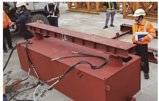
圖 8 支撐架頂部垂直及縱向移動機構
