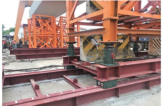
圖 7 支撐架底部橫向移動機構
