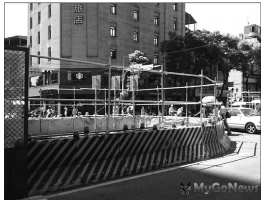
圖 2 紐澤西護欄加上 GIP 鋼管與透明帆布
