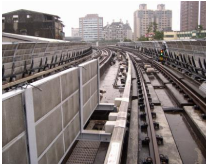
高架橋彈性基版軌道
