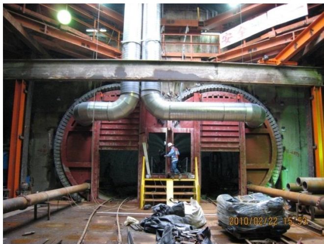
圖 7.3-9 CA450A 標 DOT 發進鑽掘完成斷面及防洪閘門
