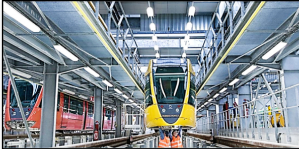
圖 12 單一立柱型式檢修平台
