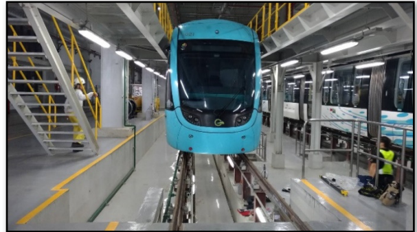
圖 10 淡海輕軌柱式檢查機坑
