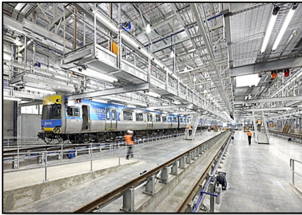
圖 13 懸吊式支撐檢修平台
