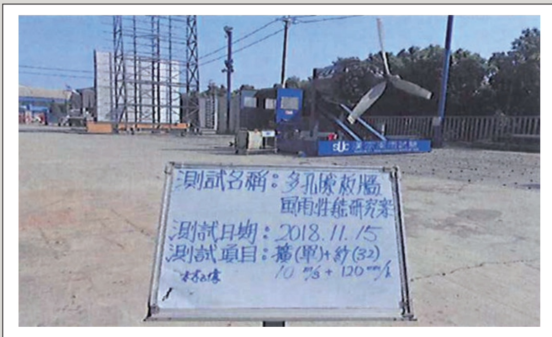
圖32 多孔隙牆板風雨試驗之現場場景照片
