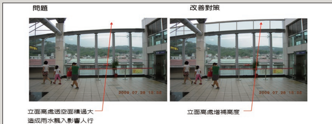
圖15 文湖線劍南路站防潑雨改善對策示意圖(二)
